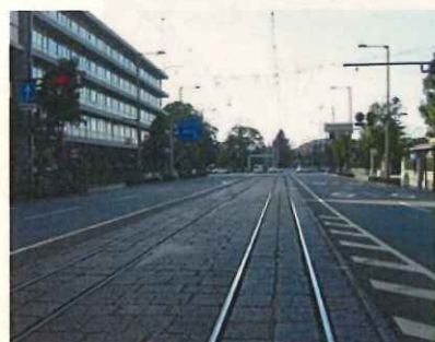
軌道用架線類を集約した例（松山市）
