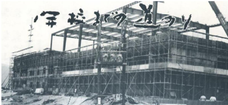
着々と進む建設中の校舎
