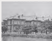
復旧工事完成（明治44年）後
