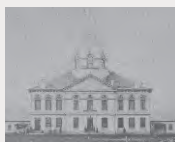
開拓使札幌本庁舎（明治6年）
