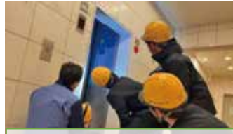
エレベーターの点検など、マンションやビルのメンテナンスを学びます。
