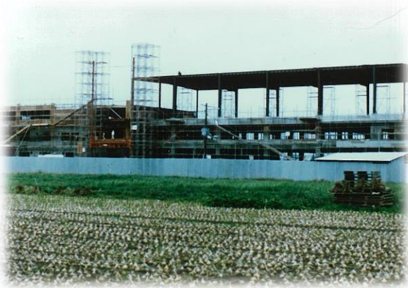
S50年 札苗中学校の校舎建築工事の様子
